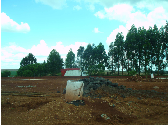
Foto – Drenos de gás
