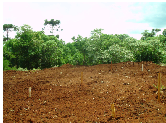
Foto – ETE - Vala de infiltração
