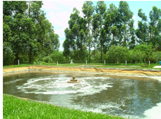
Foto – ETE - Lagoa aeróbica
