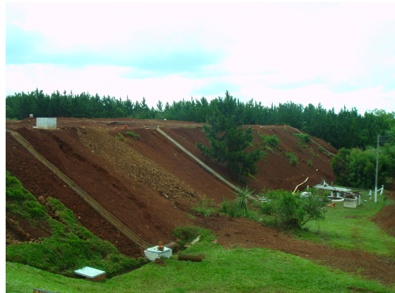
Foto – Drenagem do talude
