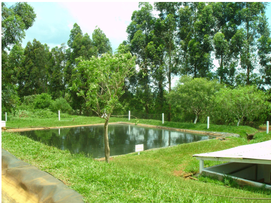
Foto – ETE -Lagoa de maturação
