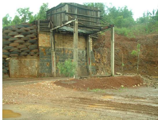
Foto – Local de Transbordo (parte inferior)
