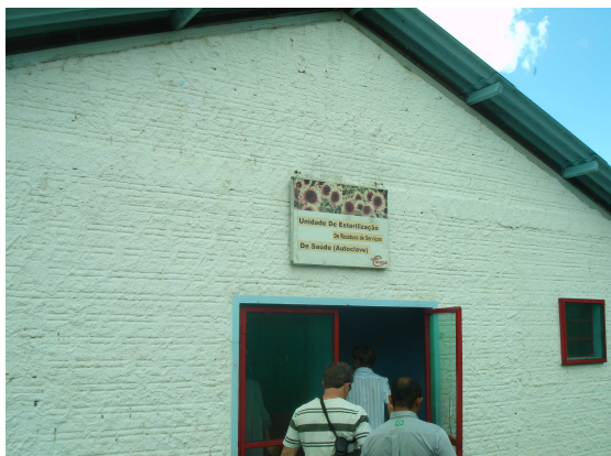
Foto – Unidade de esterilização (resíduos da saúde)
