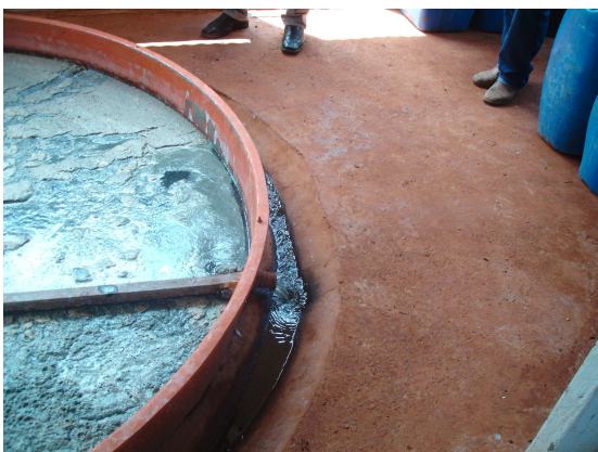
Foto – ETE –Tratamento Químico
